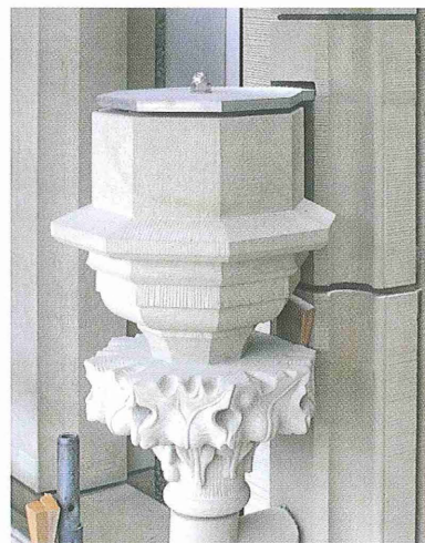
Vasenkonsole mit darüber liegender Stahl-Kragplatte zur Figurenaufstellung
